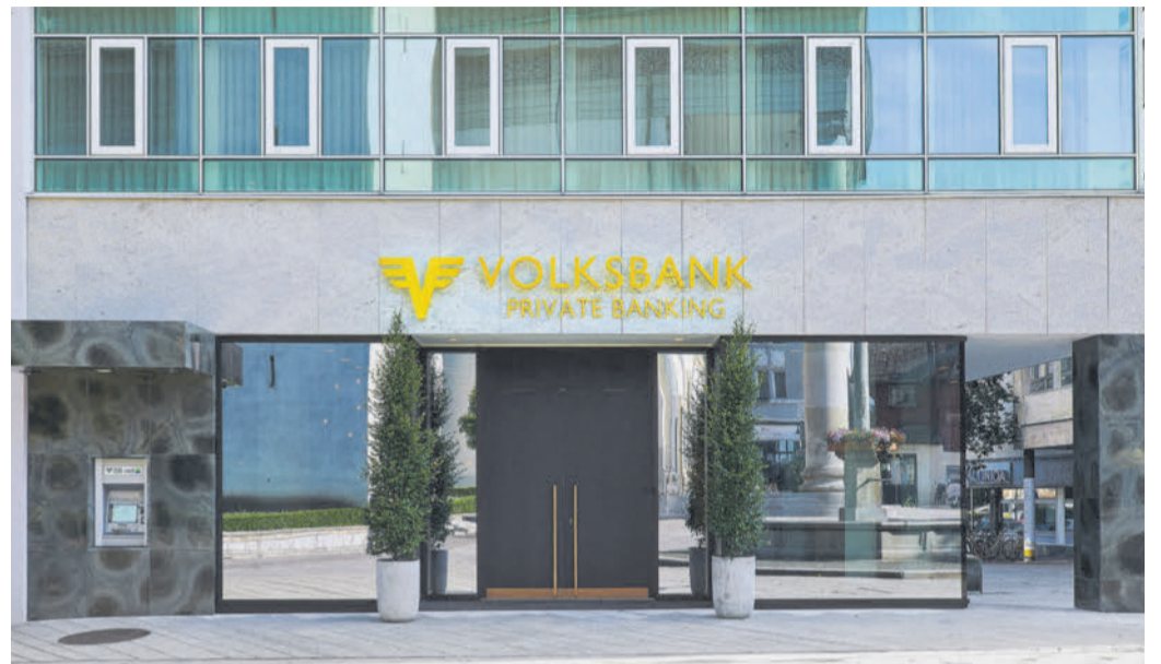
Bereits 2016 wurde auf ein neues Konzept umgestellt.
